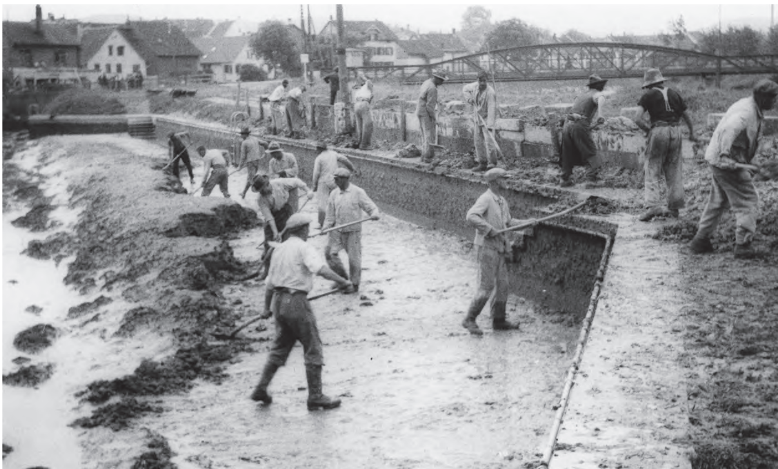
Die künstlich angelegte Kanalerweiterung erwies sich als Fehlkonstruktion. Einmal im Jahr musste das Bad von mehreren Arbeitern «entschlamm» werden.
